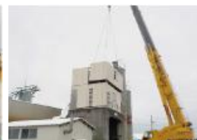
クレーン解体
