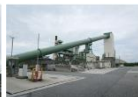
プラント解体前
