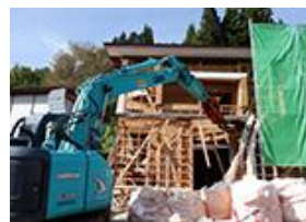
建物躯体重機解体
