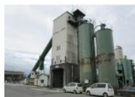
プラント解体前
