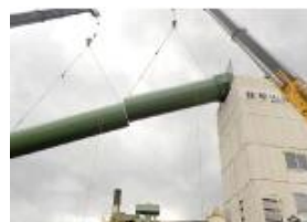
クレーン解体
