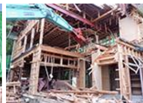
建物躯体重機解体
