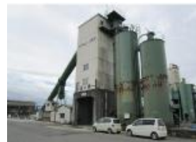
プラント解体前
