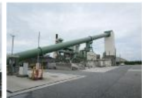
プラント解体前
