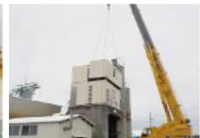
クレーン解体
