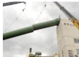
クレーン解体
