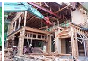
建物躯体重機解体
