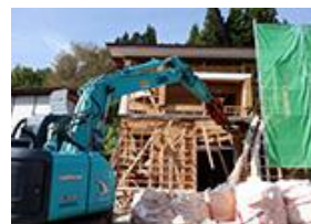
建物躯体重機解体
